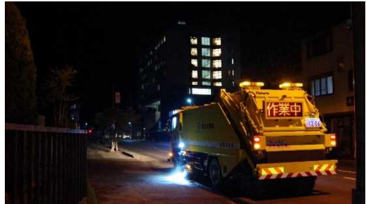
7月9日 路面清掃車で粉塵除去 (熊本県人吉市)
