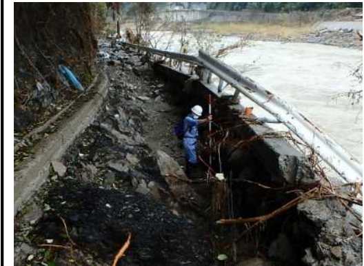
7月16日 被災した道路の現地調査 (熊本県球磨村)
