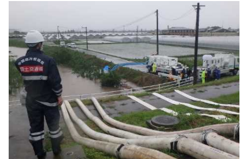
排水活動状況(福岡県久留米市)
