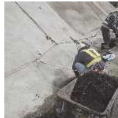
作業時なるべく離隔を確保
