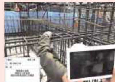
Webカメラを利用した遠隔検査
