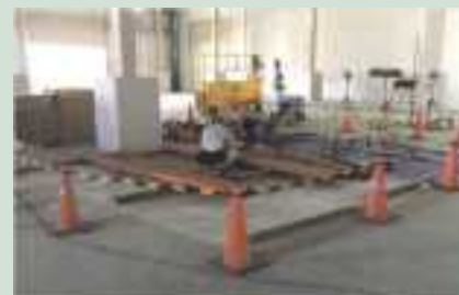
工事エリアの区画を設定して作業
