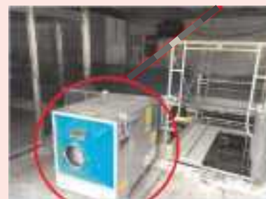
集塵機を設置し室内の換気を実施
