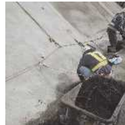
作業時なるべく離隔を確保
