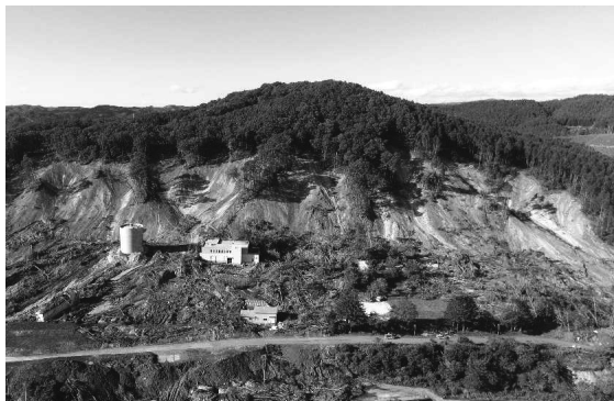
厚真町富里地区では、斜面崩壊により浄水場施設等への被害が発生
