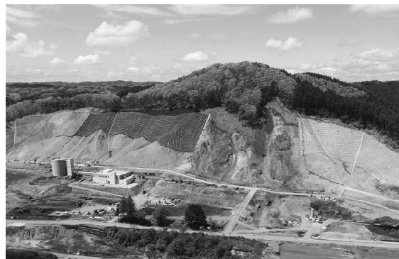
令和2年7月に浄水場からの給水が再開し、再度災害防止のための法面工事も進む
