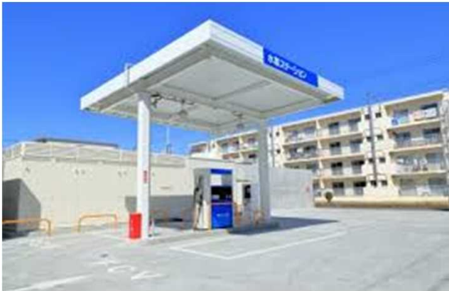
＜水素ステーション＞
