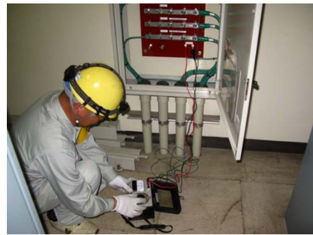
図 3-7 接地抵抗の計測
