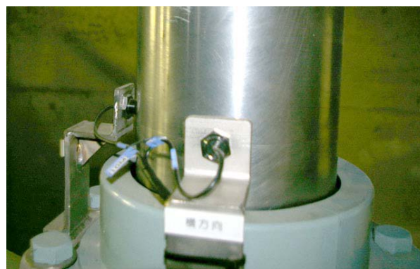
固定金具による常設方式
