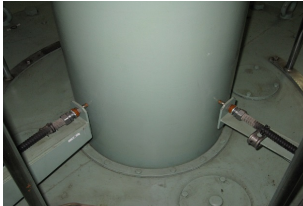
図3-11 非接触式変位センサ設置例
