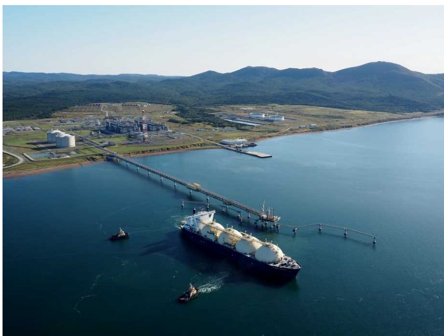
写真12 プリゴロドノエ港（サハリン・クリル・カムチャッカ海洋港局HPより）
