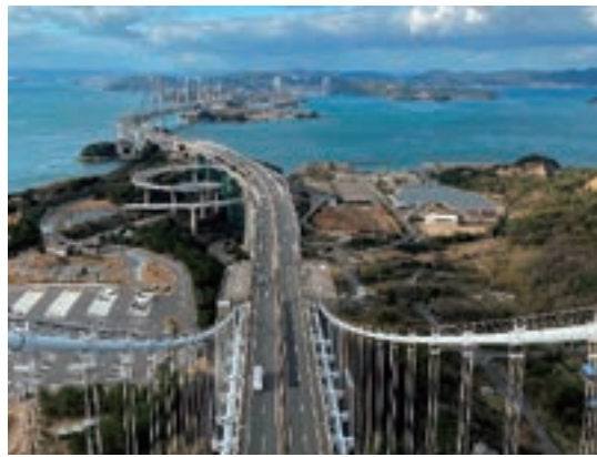
北備讃瀬戸大橋より岡山側を望む
