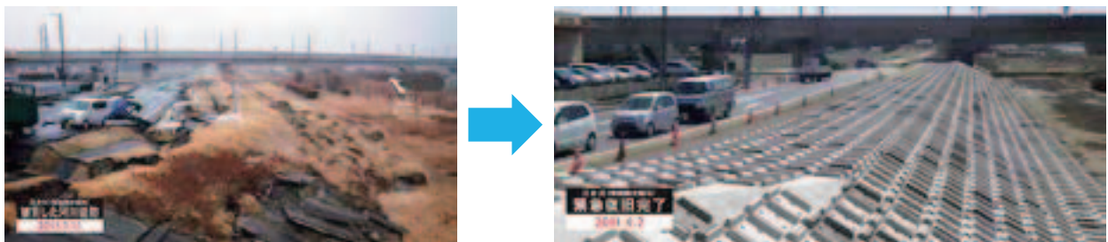
図表 I -1-2-3 河川堤防の仮復旧状況
