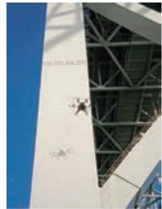
ドローンによる塗装点検手法の検討
