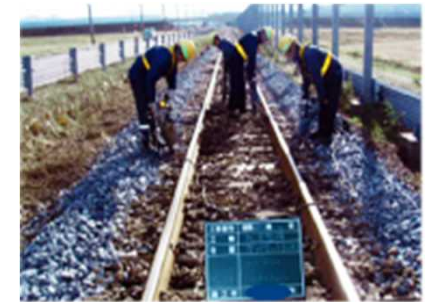
レールの修繕
