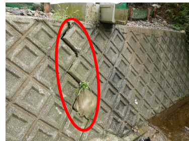
【写真②(基礎の洗堀による護岸の変状)】
