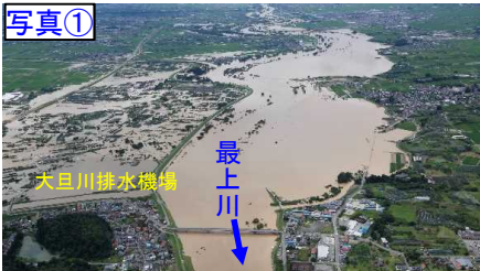
被害状況(令和2年7月豪雨)
