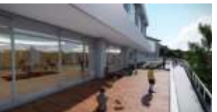
南館 1階デッキスペース
