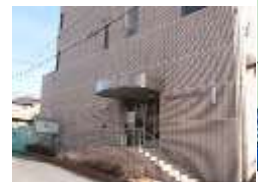
1992（平成4年） 藤崎図書館
