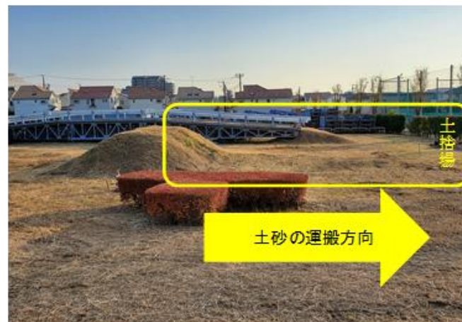
人土工事ヤード 既存盛土をほぐし状態にして、作業実施
