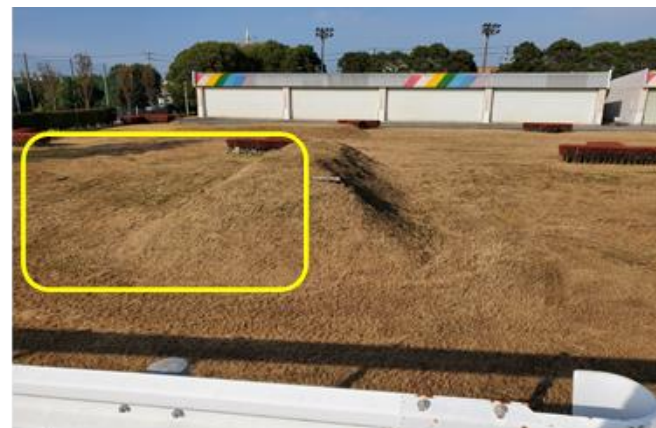
人土工事ヤード 既存盛土をほぐし状態にして、作業実施
