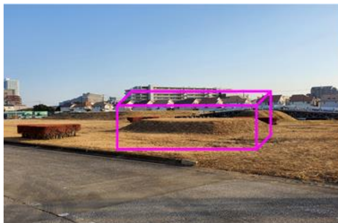
仮設足場での作業① 足場ステージ構築
