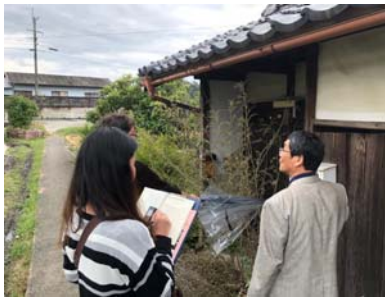
10/22 管理不全・危険空家講習①
