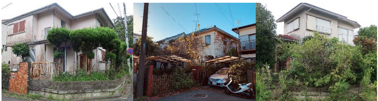
住宅地内の(推定)空き家
