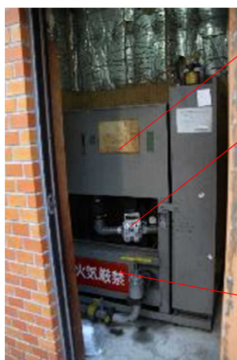
写真2 油圧パワーユニット外観
