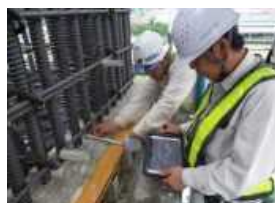
タブレット活用による検査
