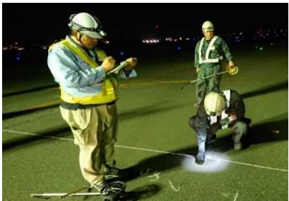
<ひび割れ計測>
