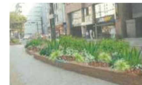
雨水を貯留しやすい土壌を使用したレインガーデンを整備
