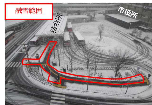
下水熱を利用した融雪事例 (新潟市)
