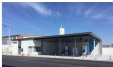
水素燃料供給ステーション ※関西エアポートHPより
