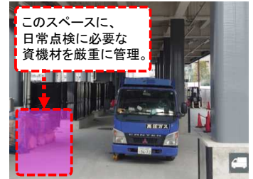
(日常点検の予定場所)
