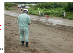
設計面と施工後の仕上がり面の高さの差を3次元的に確認
