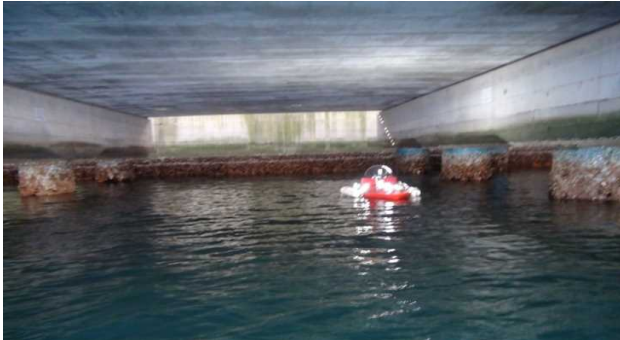
■ 栈橋での調査状況
