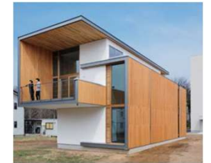
CLT工法による実験棟
