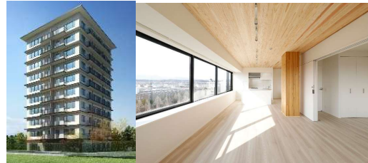
CLTを用いた10階建て共同住宅
