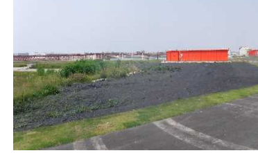
施工後(アスファルト乳剤散布)
