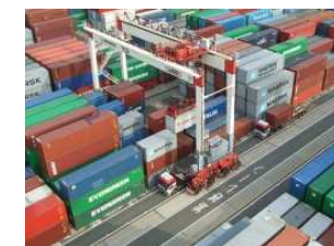
RTG(タイヤ式門型クレーン)
