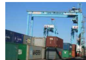
ASC(自動化スタッキングクレーン)
