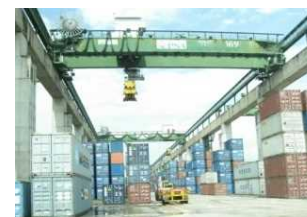
OHBC(天井クレーン)
