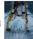
作業船の船上クレーンの波浪・風雨による動揺
