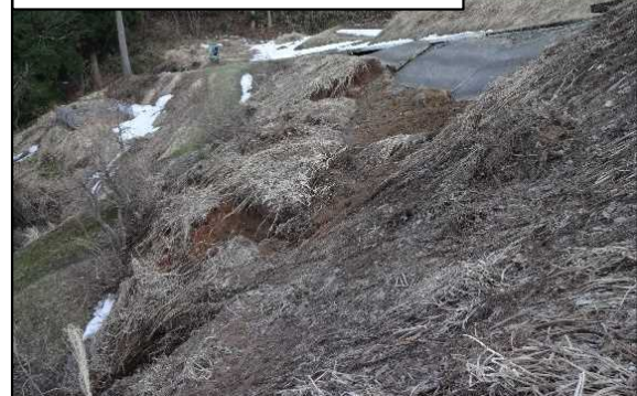
【写真②(被災状況)】
