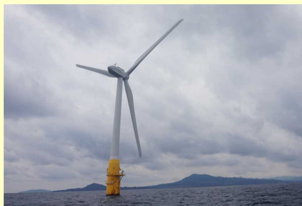
福江島の沖合で運転中の浮体式洋上風力発電所
