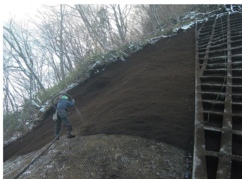
客土の吹付作業状況
