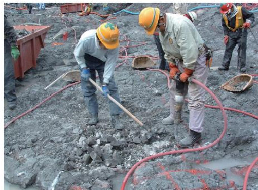
人力による岩掘削作業状況
