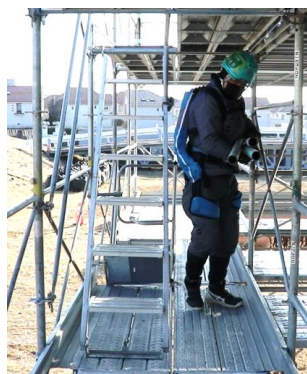
足場内の移動 (P2 装着)
