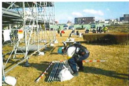
足場進入前の資材持上げ (A2 装着)
