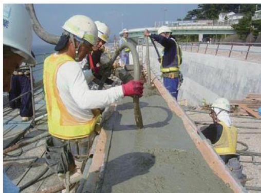
コンクリートバイブレイタによる締固め作業状況
