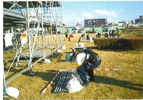
資材持上げ状況
