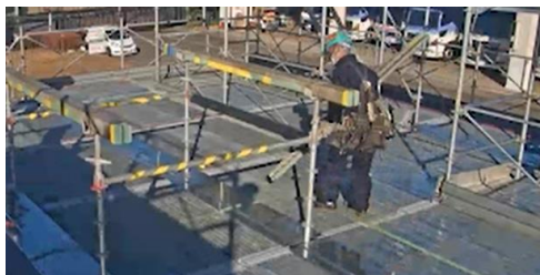
上面作業場における中腰潜り抜け運搬
