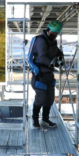
足場内の長尺物の運搬 (P2 装着)
