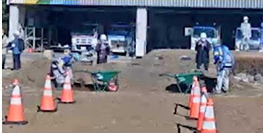
装着しての掘削(持上げ)
