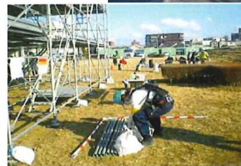
足場進入前の資材持上げ (A2 装着)
