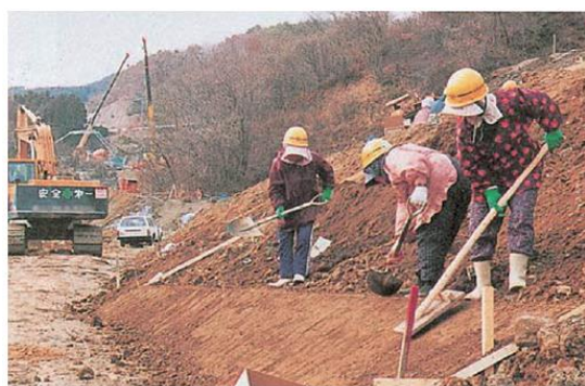
人力による土羽築立作業状況
