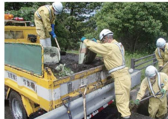
人力清掃作業状況
