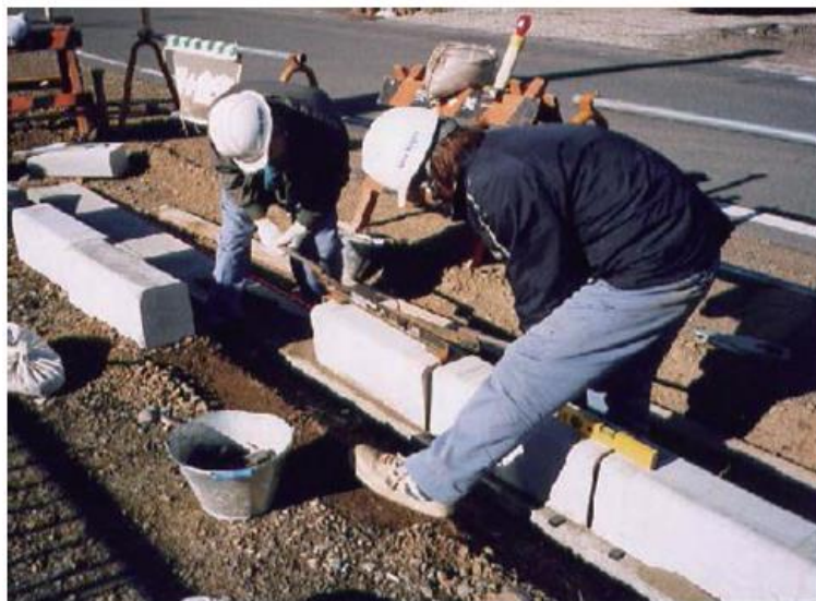
ブロック敷設
