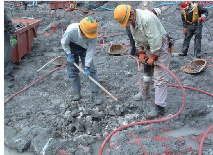
岩盤掘削、はつり工
