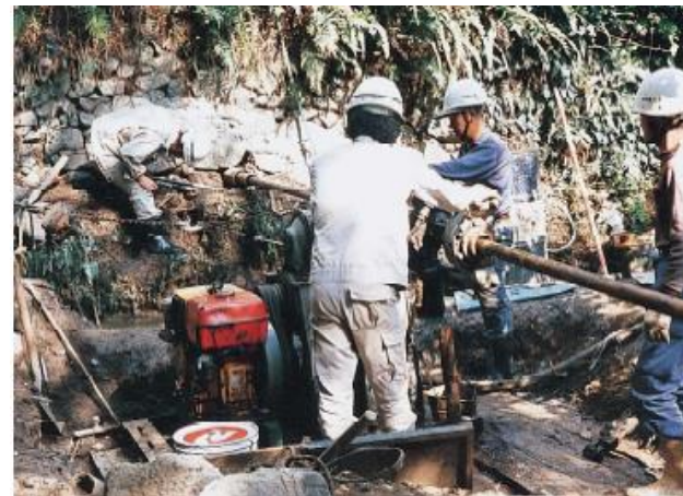
地質調査・ボーリング
