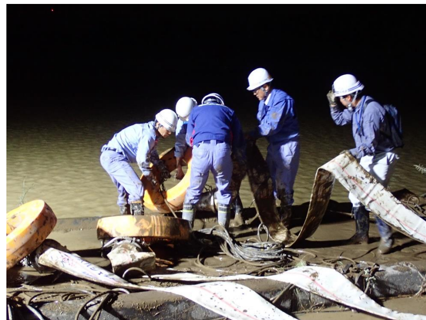
排水ホース設置
