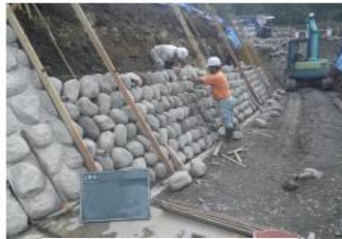
法面石材敷設
