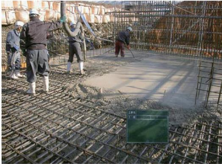
コンクリート打設
