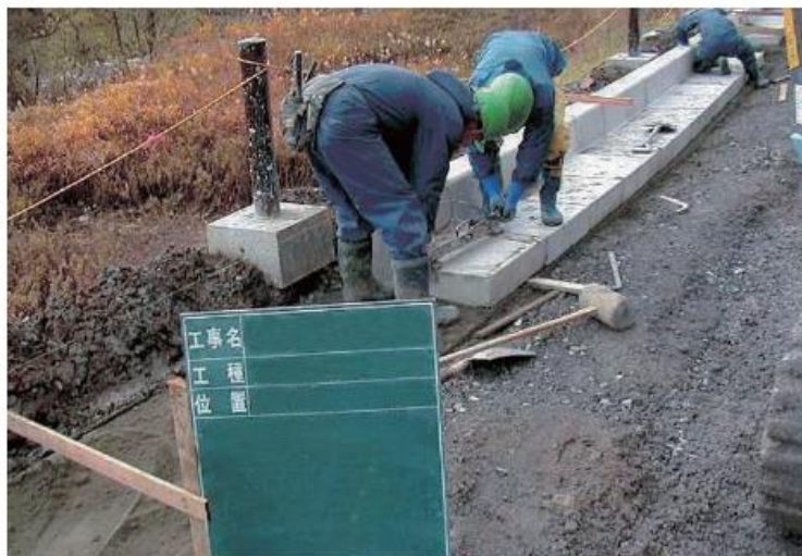
プレキャスト側溝据付
