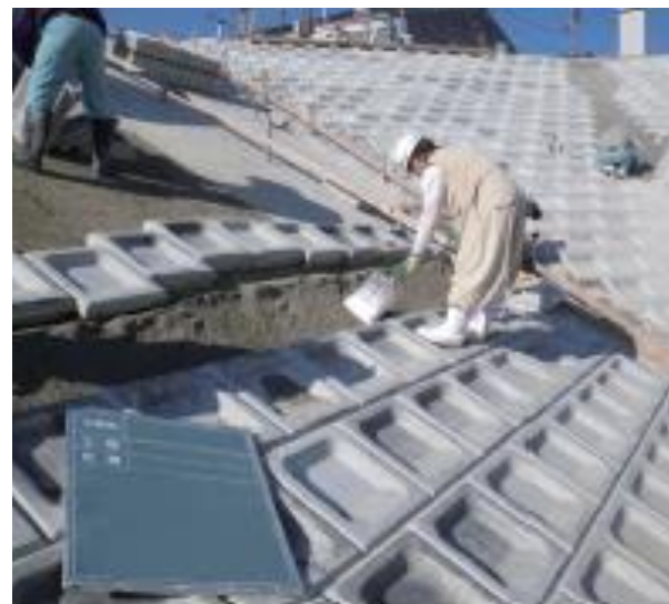
コンクリートブロック設置
