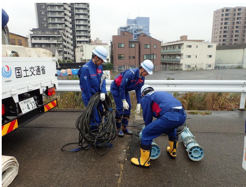
ポンプ設置搬送
