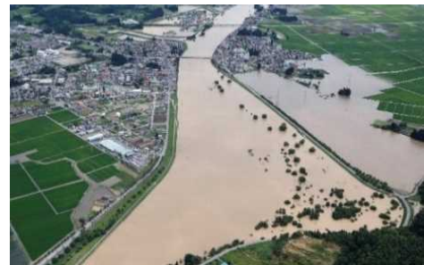
最上川の氾濫状況（山形県大石田町）
