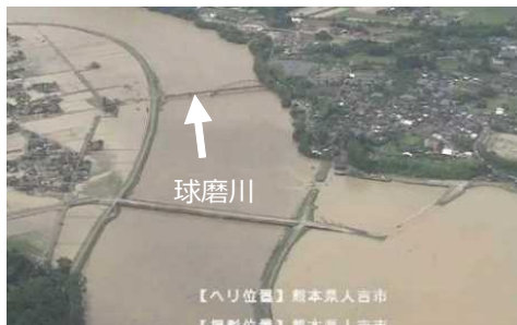
球磨川の氾濫状況（熊本県人吉市）
