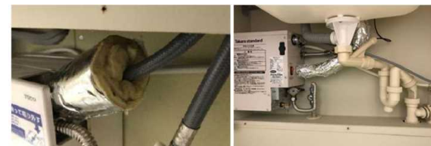
(給湯配管の保温工事)
