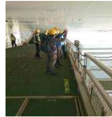
桁外面作業車へ 珍しい景色
