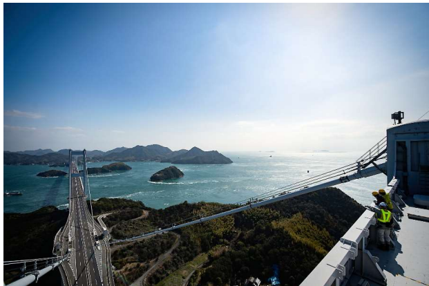
ビルの52階に相当する主塔に登頂
