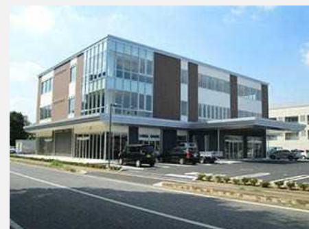
高い階高の3階建て鉄骨造
