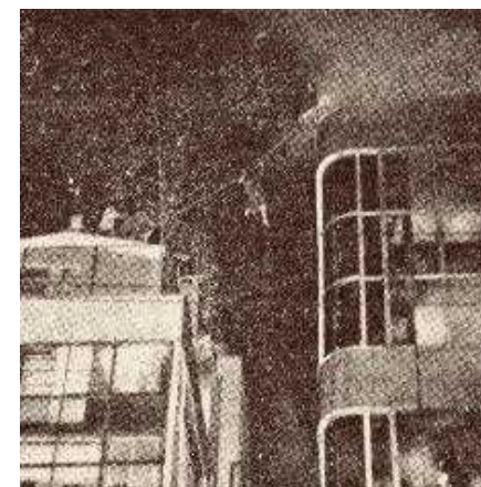
金井ビル火災（昭和41年）
