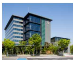
⑩松尾建設㈱本社ビル
