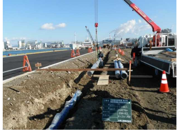
写真8-1-1 水道管の復旧工事（宮城県石巻市） (出典) 厚生労働省資料
