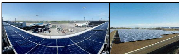
(図-9 太陽光発電設備)
