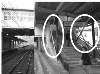
鉄骨ブレースによる
