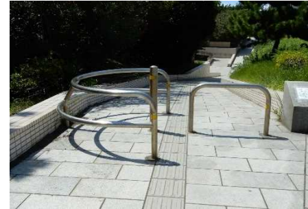
【C型ゲート】 大型車椅子が通行できない。 普通型車椅子も通行しにくい
