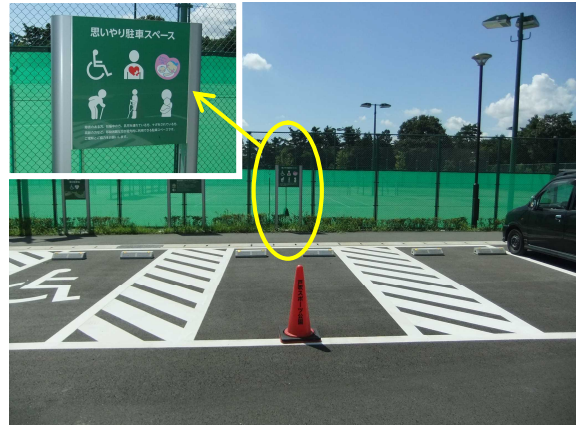
・駐車場内に、車椅子使用者駐車施設の他に、障害者、妊婦、乳幼児連れ、高齢者など移動困難な方が優先的に利用できる駐車スペースを確保（東京都八王子市戸吹スポーツ公園）
