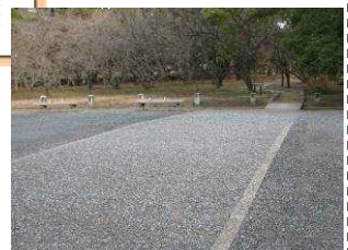
砂利の風合いや景観に配慮した舗装（主苑路の横断部）
