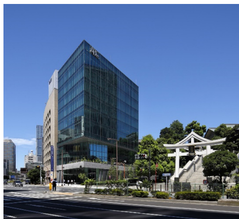
写真 1-1-1 : エービーシー商会本社ビル
