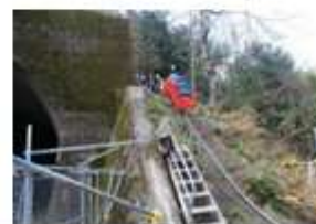
資材運搬のための索道
