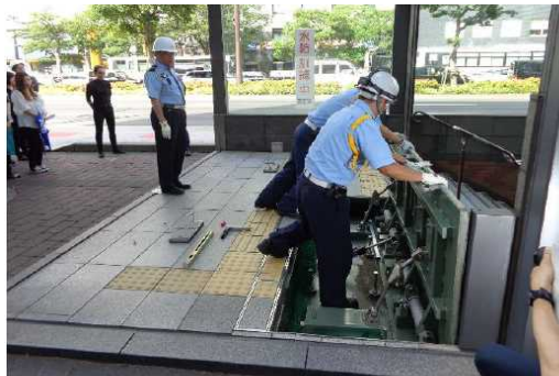
手動起上式止水板設置
