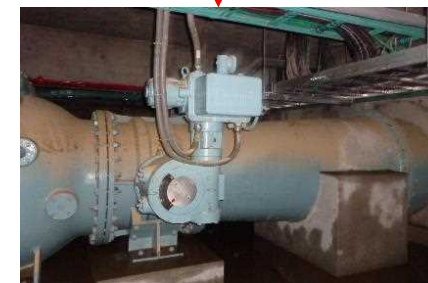
被災したポンプ吐出弁電動機
