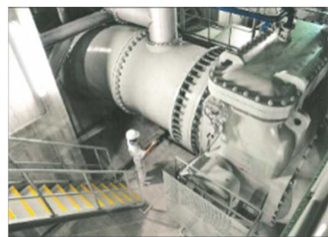
雨水ポンプの整備
