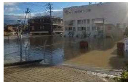
ポンプ場浸水状況
