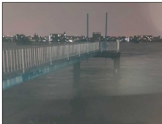
東日本台風の際の河川の状況
