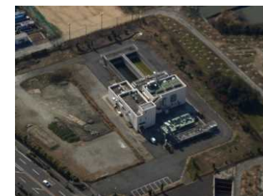
浦安ポンプ場 平成27年3月 356m 3 /min増強 排水能力 792m 3 /min
