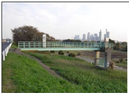
堤外側でゲート进行操作する樋門
