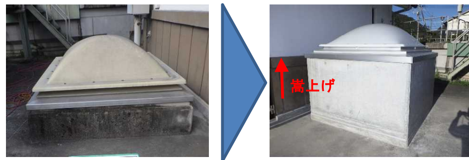
トプライトの止水対策 (左:実施前 右:実施後)
