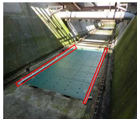
飛散防止金具の設置
