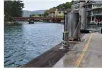
天橋立機橋安全整備(係船柱・足場板)
