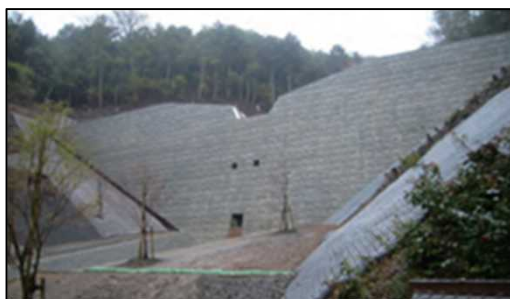
従来の不透過型砂防堰堤
