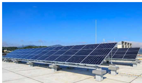
<高山地方合同庁舎> 岐阜県高山市 20 kW
