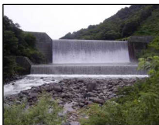
小水力導入前の砂防堰堤
