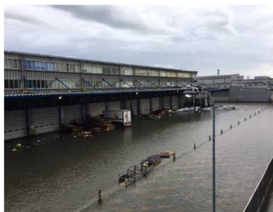
関西空港国際貨物地区の浸水
