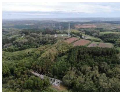
台風 15 号により倒壊した鉄塔
