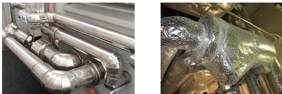
図 2-2-18 配管保温材の施工
