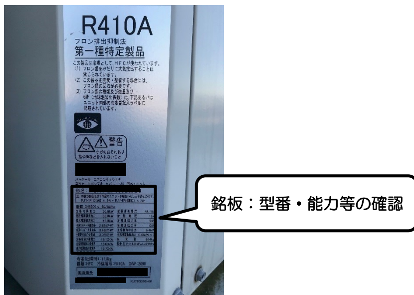
図 2-2-13 熱源機の型番表示の例（パッケージエアコンディショナ（空冷式））
