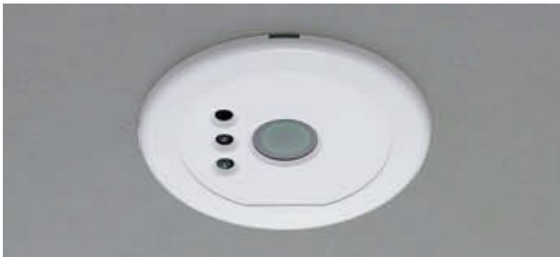
図 2-2-6 明るさ検知制御のセンサーの例
